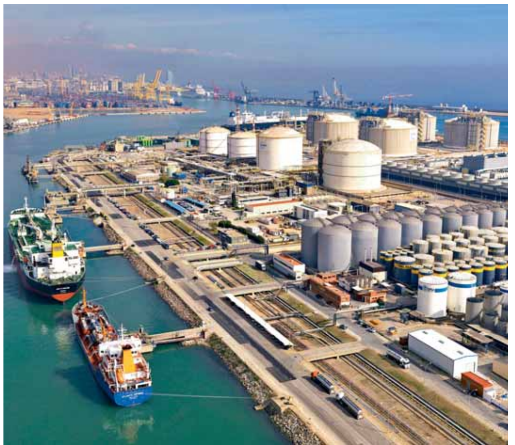
La planta de Enagás en el Puerto de Barcelona está situada en la zona conocida como muelles de la Energía. Foto J.J.M.
